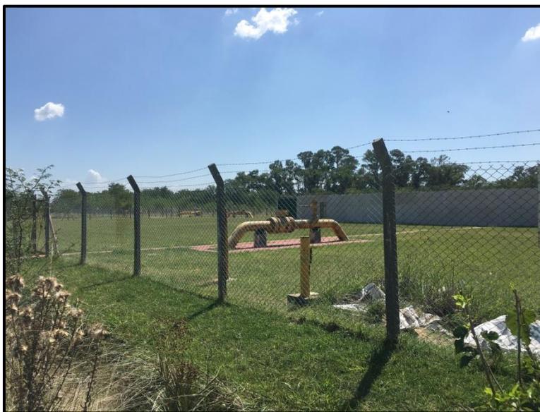
*Imagen N° 2.16: Válvula de derivación a Centra Termoeléctrica GENELBA - Pampa Energía.
